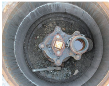
地下に埋設された消火栓の内部
